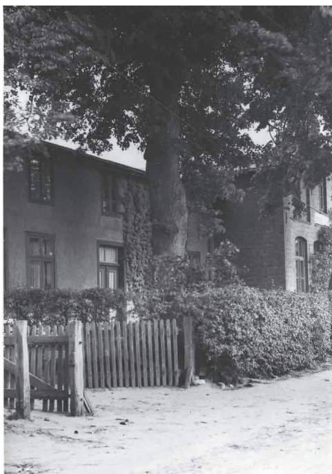
Das Schulgebäude in Klockenhagen
